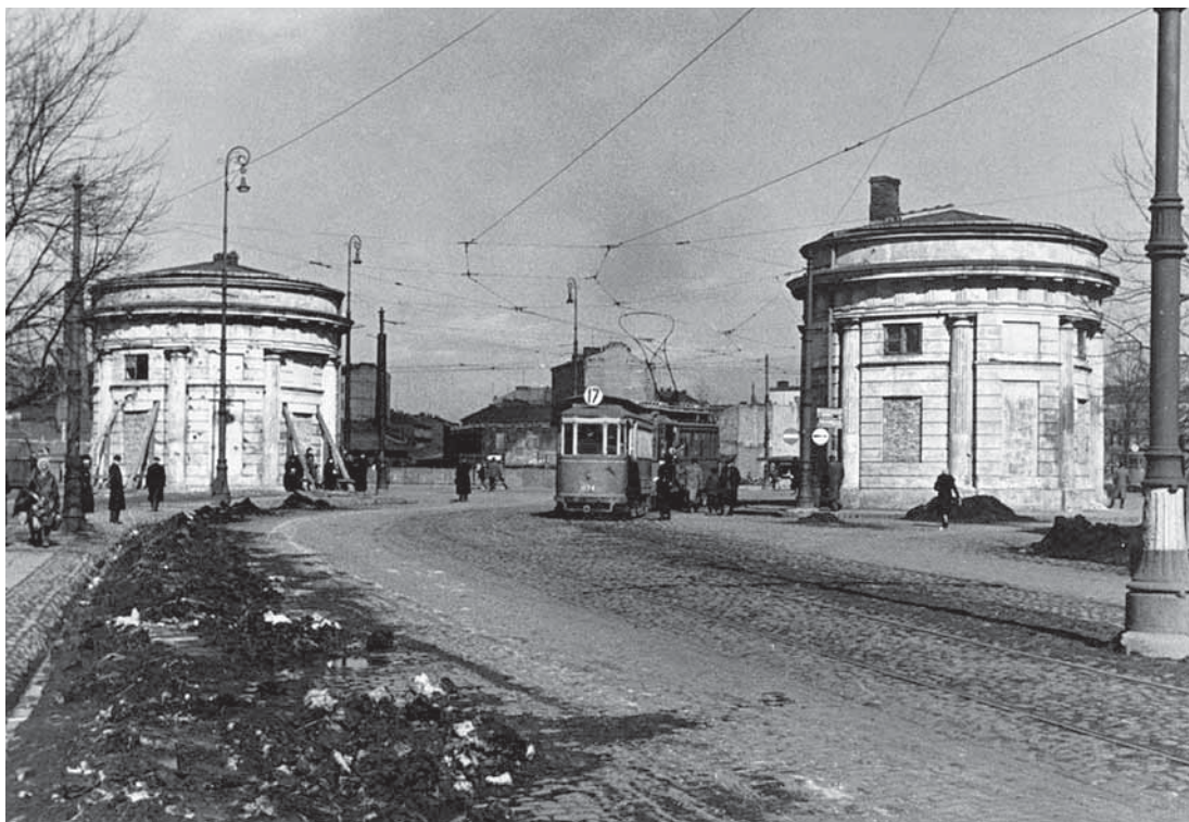
Ilustracja 5-9. Rogatki Jerozolimskie — widok w kierunku wschodnim. Stan w 1941 roku. Fot. nieustalony. Wg Zb. ZAP WAPW, Fototeka , Warszawa 1922–2020, sygn. robocza 001574
