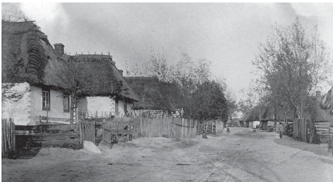
Ilustracja 3-28. Powiat Łuków, wieś Poizdów, droga wiejska (46.01)
