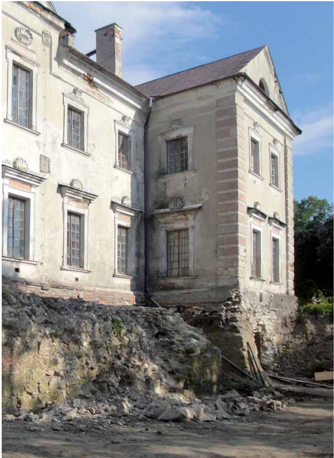
Ilustracja 2-20. Gardzienice, pałac — fragment elewacji zachodniej z ryzalitem południowo-zachodnim po odgruzowaniu dolnej kondygnacji. Fot. M. Brykowska, 2011
