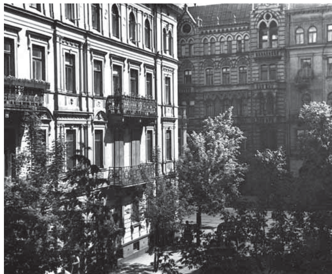
Ilustracja 5-14. Zabudowa w otoczeniu skrzyżowania ulicy Wilczej i Aleji Ujazdowskich. Stan w pierwszej połowie 1939 roku. Fot. W. Kalinowski. Wg Zb. ZAP WAPW, Fototeka , Warszawa 1922–2020, sygn. robocza 000882
